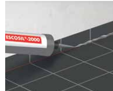
3 Einbau von ESCOSIL-2000
